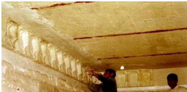
تصویر ۲۵. اقدامات حفاظتی غیر تخصصی و استفاده از تیر آهن و حذف تزیینات (آرشیو پایگاه میراث جهانی باغ اکبریه)
