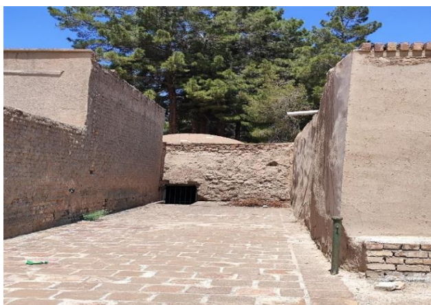
تصویر ۳. بازگشایی مسیر از داخل روستای اکبریه برای استفاده از حمام
