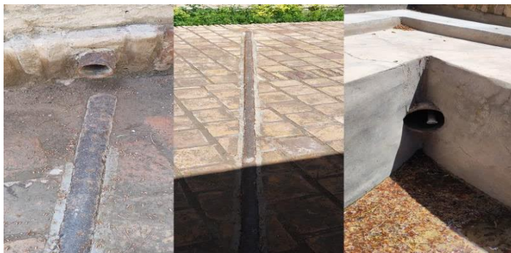
تصویر ۲. لوله‌کشی و لوله‌گذاری باغ و عمارت اکبریه
