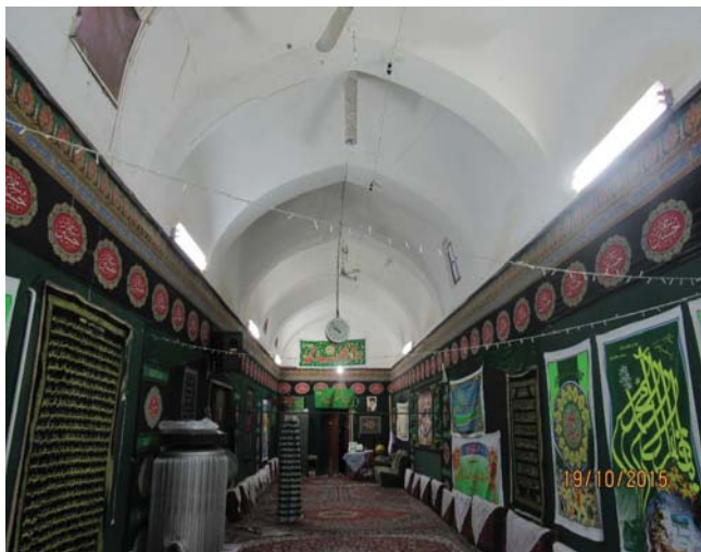
تصویر ۱) نمایی از ضلع غربی اتاق سرپوشیده مخصوص عزاداری حسینیه بی بی عروس با پوشش طاق و تویزه (عکاس: مرضیه فاریابی)
