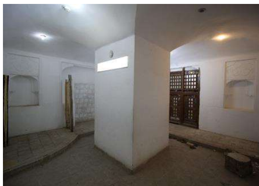
تصویر ۷. ایجاد ستون و سقف و مجزا نمودن طبقات
