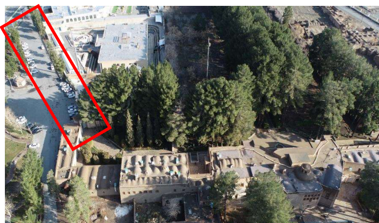
تصویر ۱۲. عکس هوایی از جاده مسیر ورودی به باغ اکبریه (ضلع غربی) (آرشیو پایگاه میراث جهانی باغ اکبریه)
