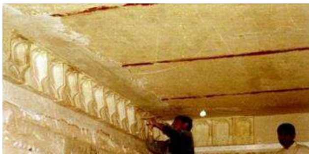
تصویر ۲۵. اقدامات حفاظتی غیرتخصصی و استفاده از تیر آهن و حذف تزیینات (آرشیو پایگاه میراث جهانی باغ اکبریه)
