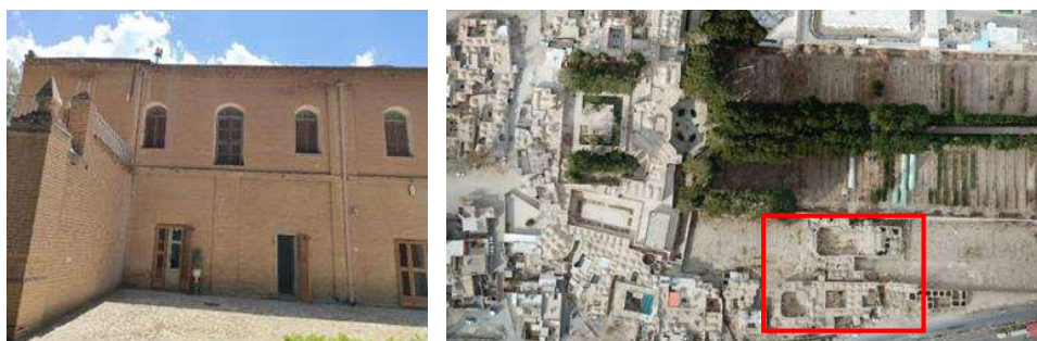
تصویر ۱۵. محصور نمودن فضای داخل باغ در دو طرف درب ضلع غربی
